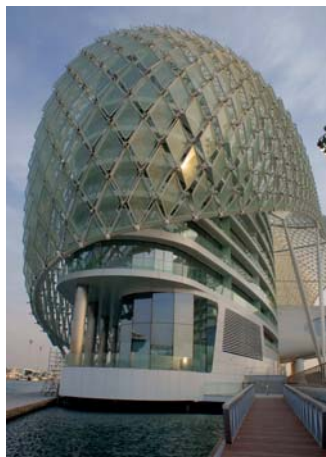
Das Stahl-Glas-Netz der 'Grid Shell' des Yas Marina Hotels in Abu Dhabi hat eine Gesamtfläche von 17 000 m 2 . Oben: Ansicht aus der Zeit des Baus im Jahre 2009. Die kleinen Bilder illustrieren ebene Glaspaneele, die in die Facetten des Netzes eingespannt werden, sowie die Knotenachsen. (Bild unten Mitte: Wikipedia; restliche Bilder mit freundlicher Genehmigung von Waagner Biro Stahlbau, Wien)
