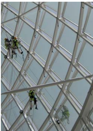
Das Stahl-Glas-Netz der 'Grid Shell' des Yas Marina Hotels in Abu Dhabi hat eine Gesamtfläche von 17 000 m 2 . Oben: Ansicht aus der Zeit des Baus im Jahre 2009. Die kleinen Bilder illustrieren ebene Glaspaneele, die in die Facetten des Netzes eingespannt werden, sowie die Knotenachsen. (Bild unten Mitte: Wikipedia; restliche Bilder mit freundlicher Genehmigung von Waagner Biro Stahlbau, Wien)
